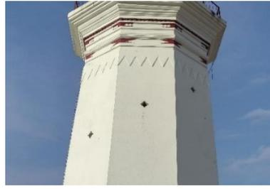
Gambar 10. Lubang Udara
